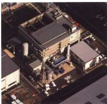
写真-1 MCFC 1000kW級パイロットプラント 1) (中部電力川越火力発電所構内)
