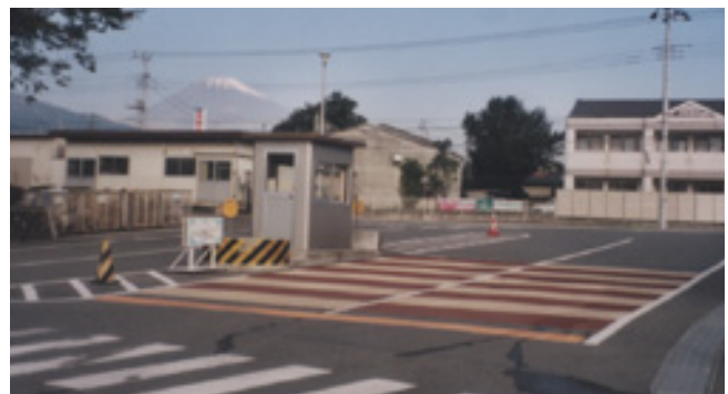
写真 1 三菱アルミニウム(株)富士製作所通用門入り口道路への滑り止め舗装 (白色部分、灰色部は比較用の現行材)
