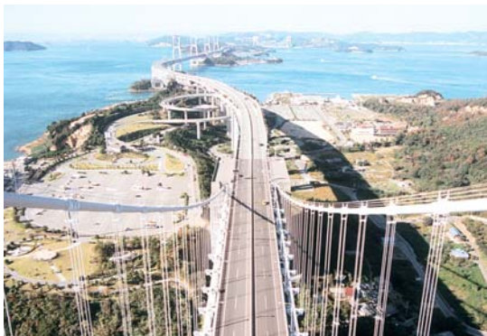
写真-2 北備瀬瀬戸大橋のメインケーブルとハンガーロープ(第2ピア橋脚主塔上から)左側に見えるのは与島パーキングエリア。(本州四国連絡橋 児島・坂出ルート(瀬戸大橋)にて)
