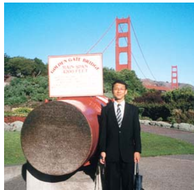
写真-3 ゴールデン・ゲート・ブリッジのメインケーブル断面と筆者(メインケーブルは直径0.92m、ワイヤ数27,572本)
