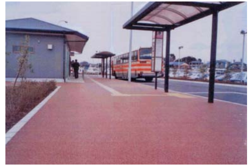
写真 - 1 道路舗装用骨材の施工例 (千葉県袖ヶ浦市バスターミナル 1998年3月施工)
