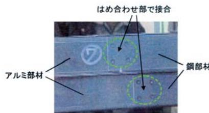
図-7 アルミ/鋼部材長手方向接合例
