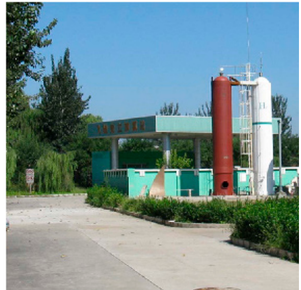
図1 北京飞驰竞立制氢加氢站 (北京飞驰竞立水素ステーション) (白い圧力容器が既設の蓄圧器、ベンガラ色の圧力容器が建設中の蓄圧器)
