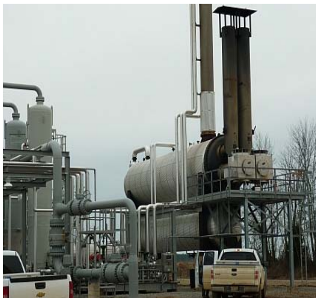
写真4 天然CO 2 輸送前の処理プラント (脱水設備、Denbury/Jackson社提供)
