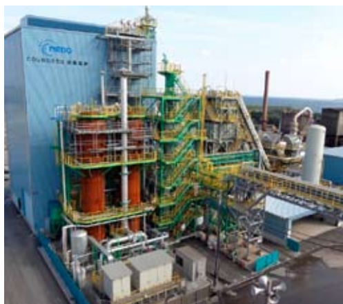
COURSE50 試験高炉
