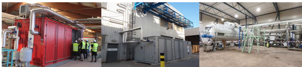
図1. DryFiciency プロジェクトで実証試験に供された高温ヒートポンプの外観* (Wienerberger 社レンガ乾燥工程に導入された閉ループヒートポンプ(左)、Agrana 社でんぷん乾燥工程に導入された開ループヒートポンプ(中)、Scanship 社の生物汚泥乾燥工程に導入された開ループヒートポンプ(右))
